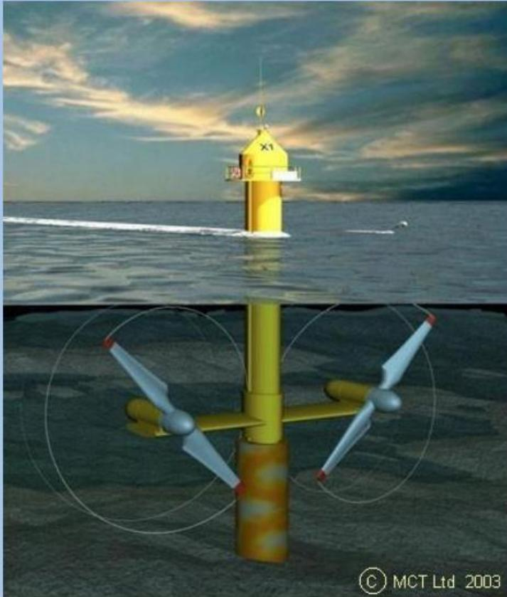
Les sortes d'hydroliennes anglaises de SeaGen ont une capacité de 1,2MW
